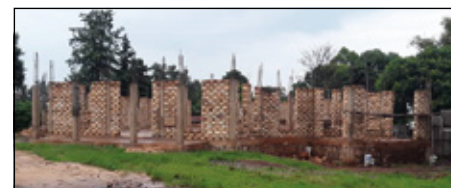
Neubau der Kirche in Kayanga
