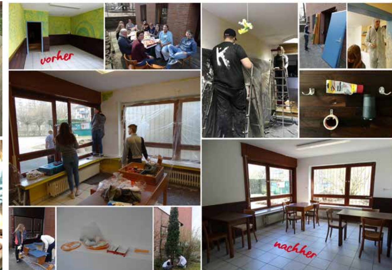
Vorher – nachher: In den Osterferien wurde auch angepackt, um die Räume in der Johanneskirche zu renovieren
